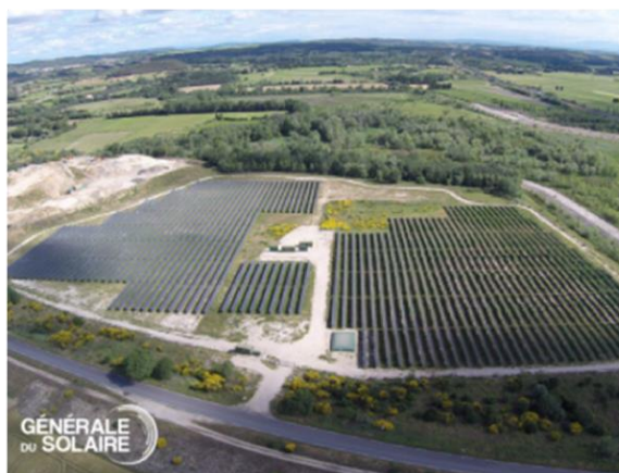
Centrale de Pujot, Gard
